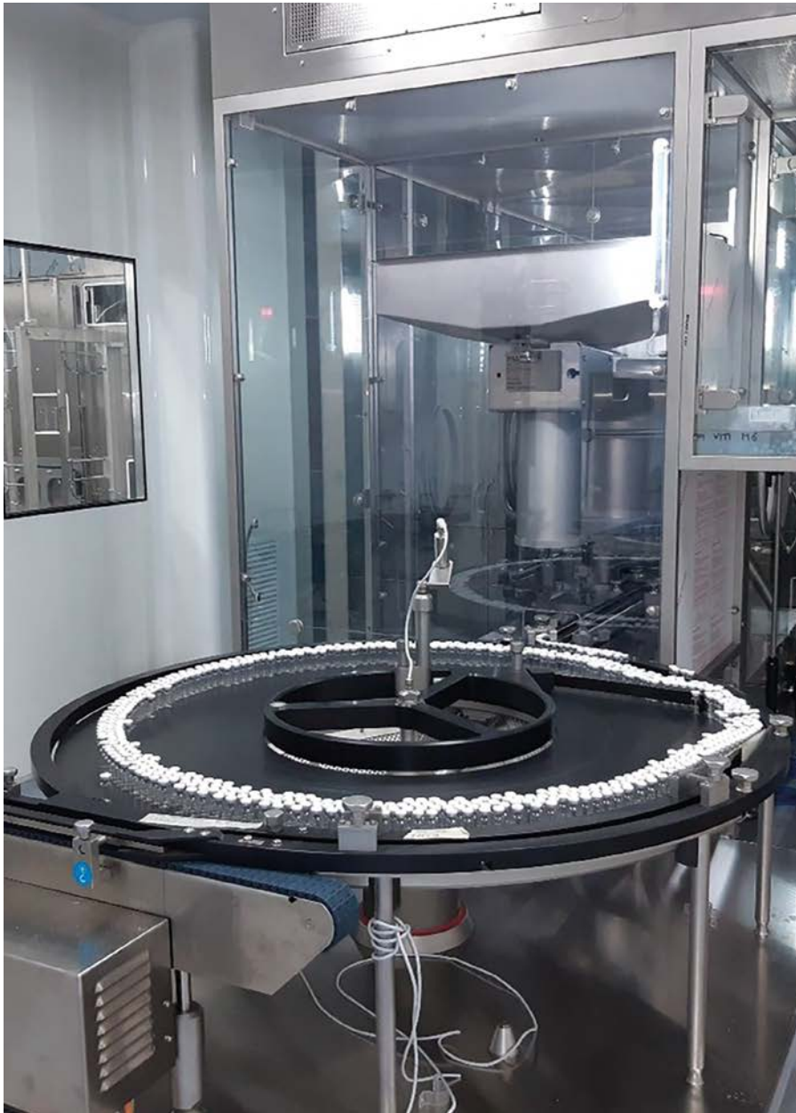
Nuevas instalaciones de la planta de inyectables de Barcelona de Reig Jofre.
