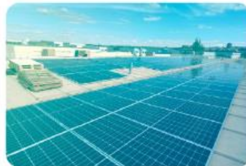
Instalación planta Toledo
